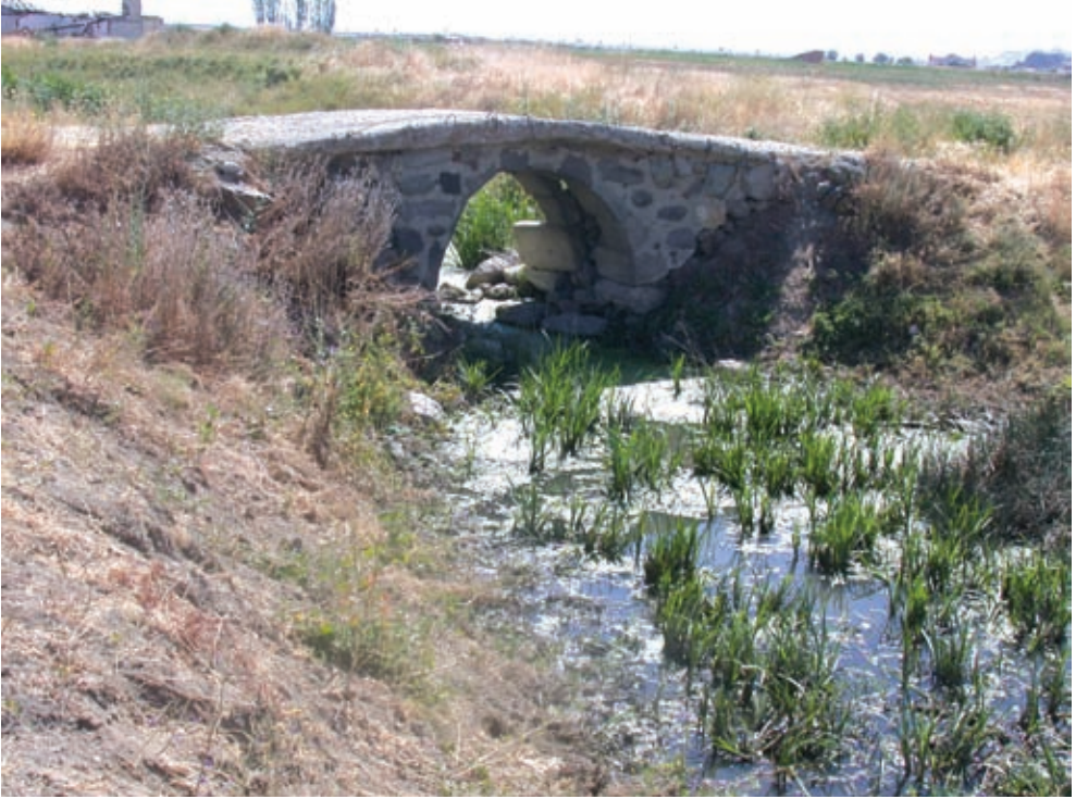
130. Hacı İbrahim Köprüsü
